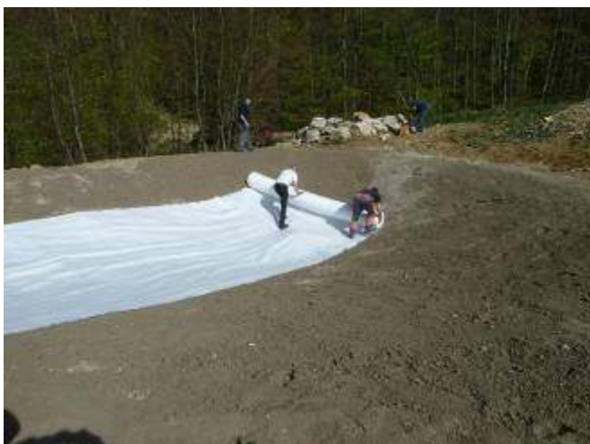
Einbau des Vlieses
