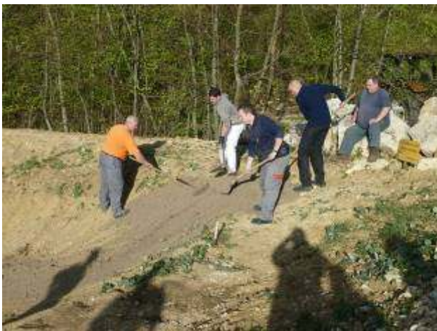
Nach dem Aushub: Einbau der Sandschicht
